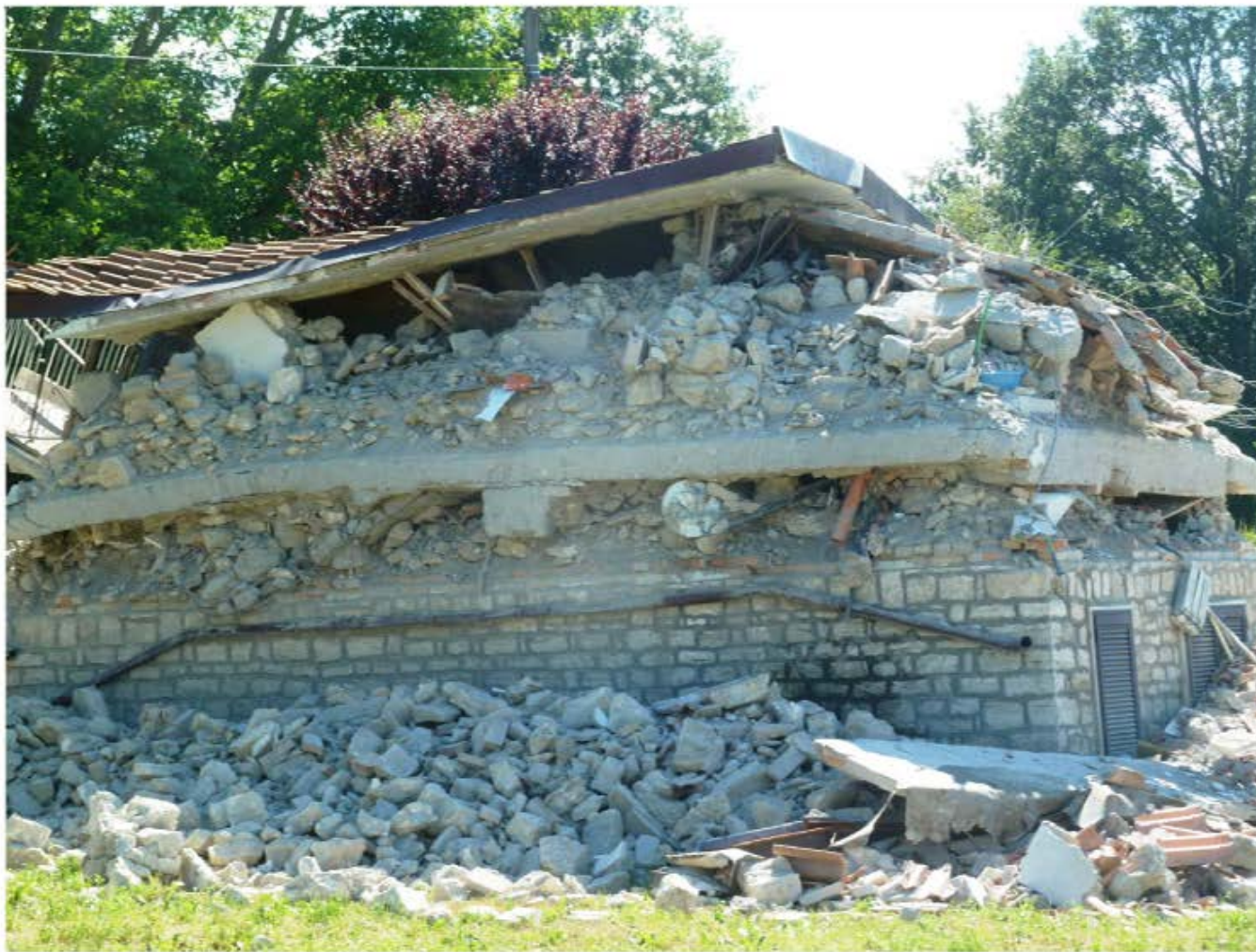
Fig. 3 - Crollo totale di un edificio in muratura con solai in CA (San Lorenzo e Flaviano, Amatrice).
