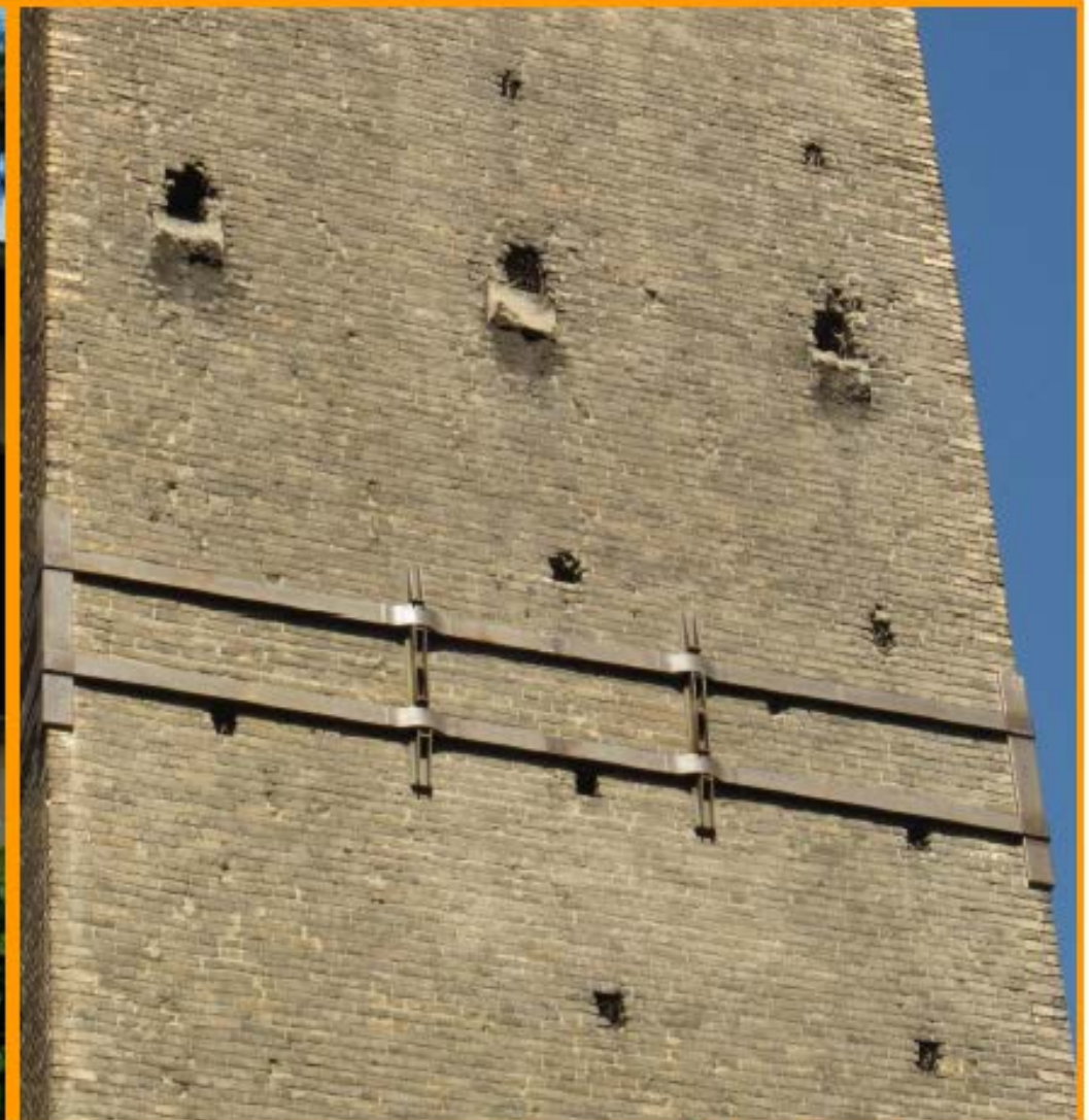
esempio di cerchiatura: Torre della Garisenda
